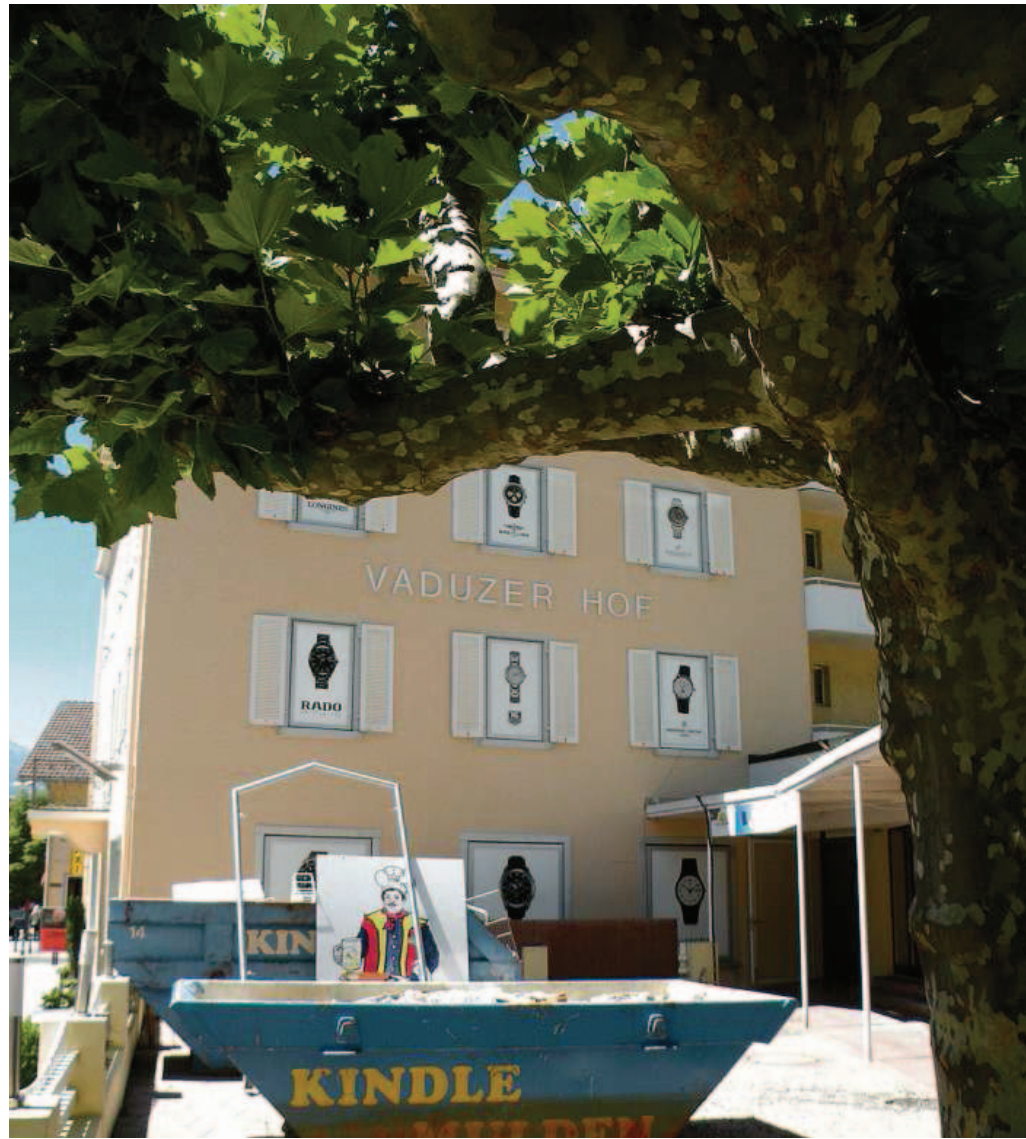
Bauschuttmulden zeugen von Veränderungen auf dem Areal des Vaduzer Hofes.
